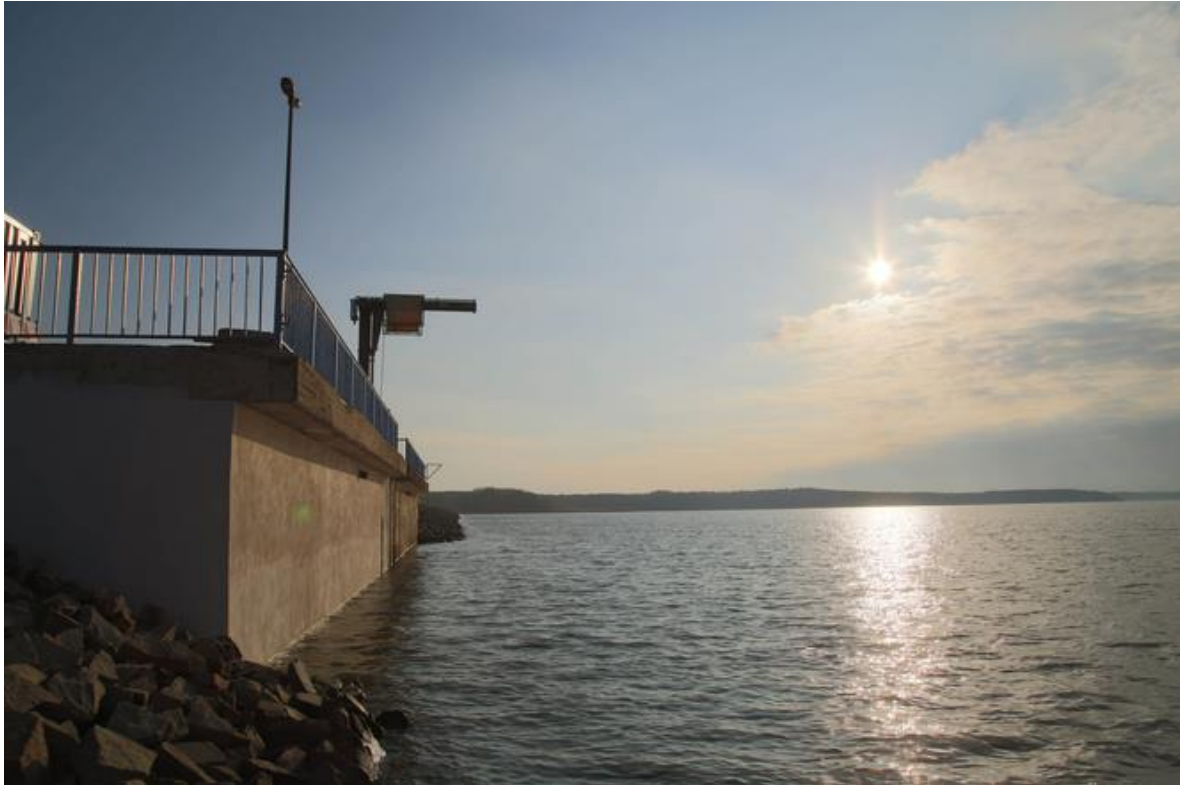
Die Staumauer des Quitzdorfer Stausees © SZ-Archiv / André Schulze
